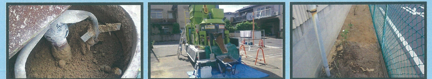
除草効果の舗装材混練り
