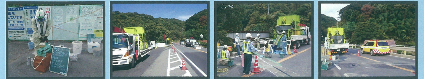
ACF24(超速硬コンクリート)による伸縮装置取替工事の様子。国土交通省 中国地方整備局
