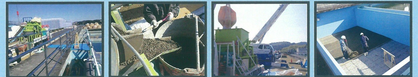
三重県ろ過施設ポラス コンクリート4.0m 3 の混練サービス
