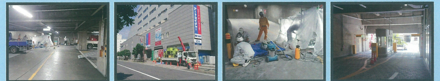
立体駐車場のスラブ補修
