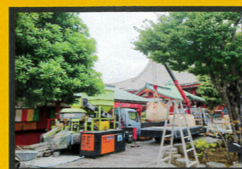
ポーラスコンクリート舗装工
