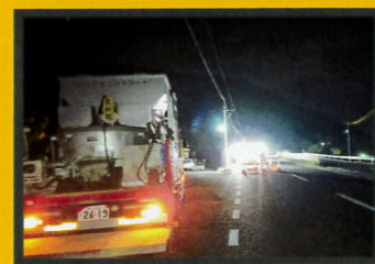
伸縮装置取替工
