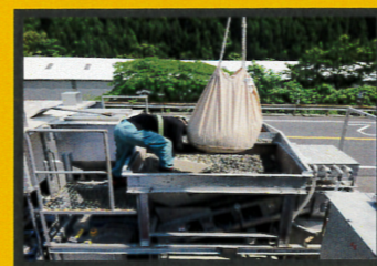
国道水路床版工
