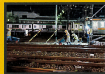
夜間軌道現場にて
